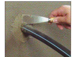
Se completează și se aduce la nivel cu un mortar cu întărire rapidă
