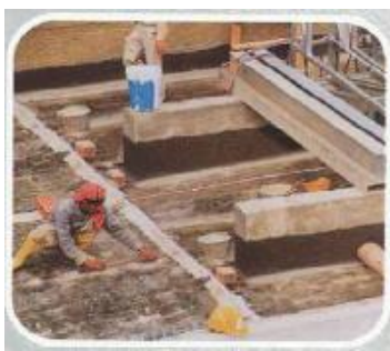
Plăci de beton
