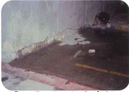
Reparație rost construcție – înainte
