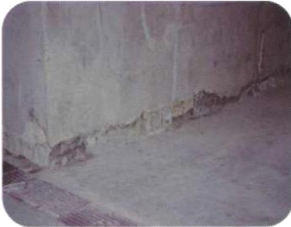
Reparație rost construcție - după
