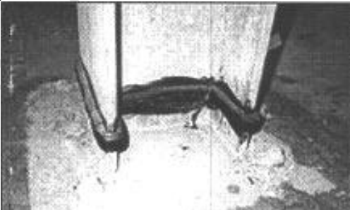
In jurul elementelor de structura din beton
