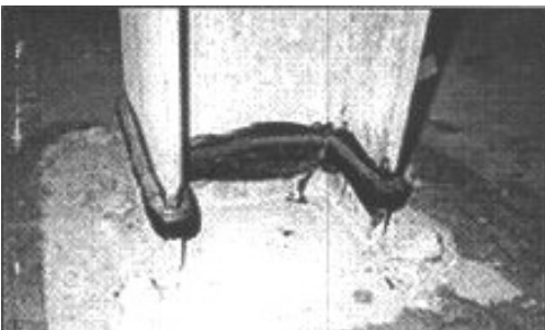
In jurul elementelor de structura din beton
