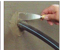
Se completează și se aduce la nivel cu un mortar cu întărire rapidă
